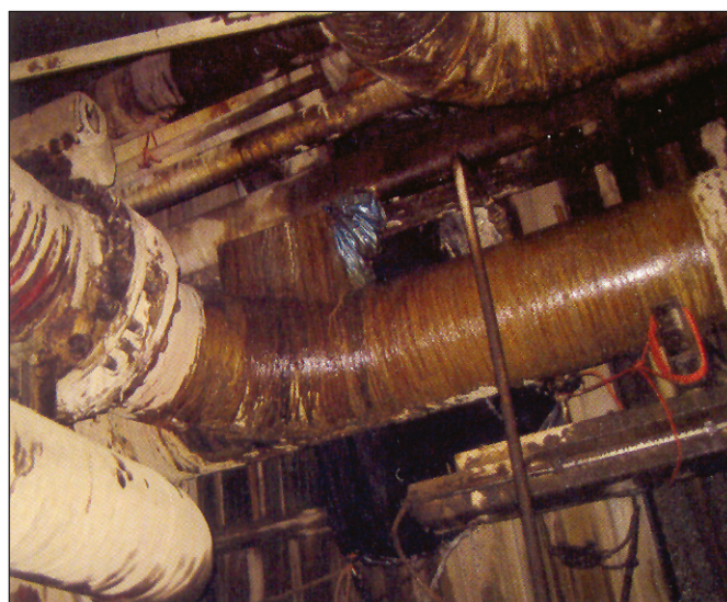
شکل ۱۲: نشستی لوله شربت در کارخانه Longchamps
