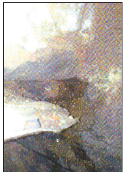
شکل ۸: نشستی آب در کوره بخار کارخانه Wanze
