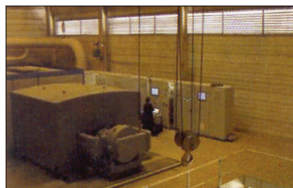
شکل ۱۴: سیستم جدید کنترل خودکار توربین در کارخانه Tienen
